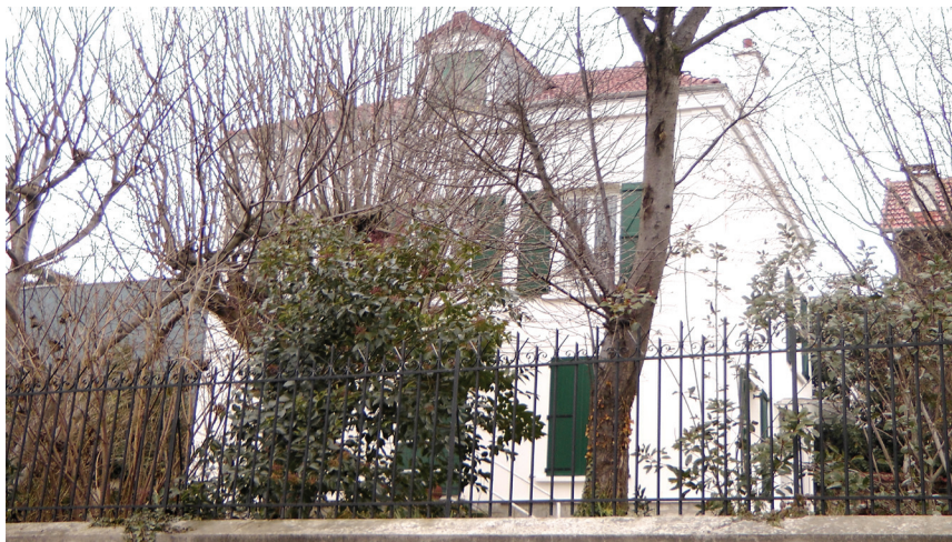
16 Rue Буйн де Перез (1923-1930)
